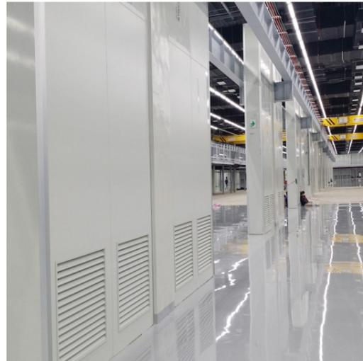
50T Steel Comb Panel은 상/하부 찬빌을 이용해서 간단히 설치가 가능한 구조로, Cleanroom의 Class에 따른 구획을 요구하는 부분과 Bay Partition에 적용되며, 설치·해체가 용이하여 Cleanroom 내부의 Lay-out변경공사에서 많이 사용 됩니다.
