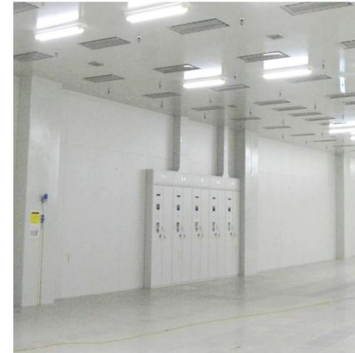
Non Caulking YSP는 Cleanroom 내부 탈가스 원인중 한가지로 대두되고 있는 Caulking 공사에 대한 문제 발생을 해결코자 기존 YSP Joint부위에 Caulking작업이 필요 없이 기밀성 및 탈부착성이 용이한 System을 개발 최근 Cleanroom 신규 프로젝트에 널리 사용되고 있습니다.
