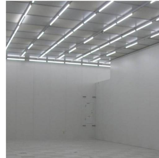
Non Caulking 50T ST'L Comb은 Cleanroom 내부 탈가스 원인중 한가지로 대두되고 있는 Caulking 공사에 대한 문제 발생을 해결코자 기존 Joint부위에 Caulking작업 필요없이 기밀성 및 탈부착성이 용이한 System을 개발 최근 Cleanroom 신규프로젝트에 널리 사용되고 있습니다.
