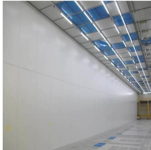
YSP (Yoochang Steel Galvanized Panel)은 Cleanroom 외벽 및 구획벽체로 사용되며 단독 골조방식 또는 석고보드 마감면에 추가로 설치되어 벽체를 구성 하는 방식으로 적용이 가능합니다. YSP는 방화 및 외기와의 향온성을 요구하는 부분에 적용 됩니다.
