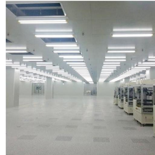
40T Steel comb Clean Panel은 Panel 성분 과 제작 형태는 Wall Panel과 동일하며, 천정에 고정하는 방식으로 구조에 대한 안전성이 확보되어 있으며, 천정 상부면에서의 유지보수가 가능한 System입니다.
